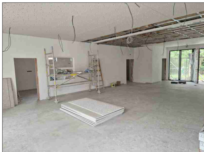
Ve velkém sále proběhla montáž akustických desek...
