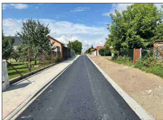
Nový chodník a komunikace s dostavbou inženýrských sítí v Sadové ulici
