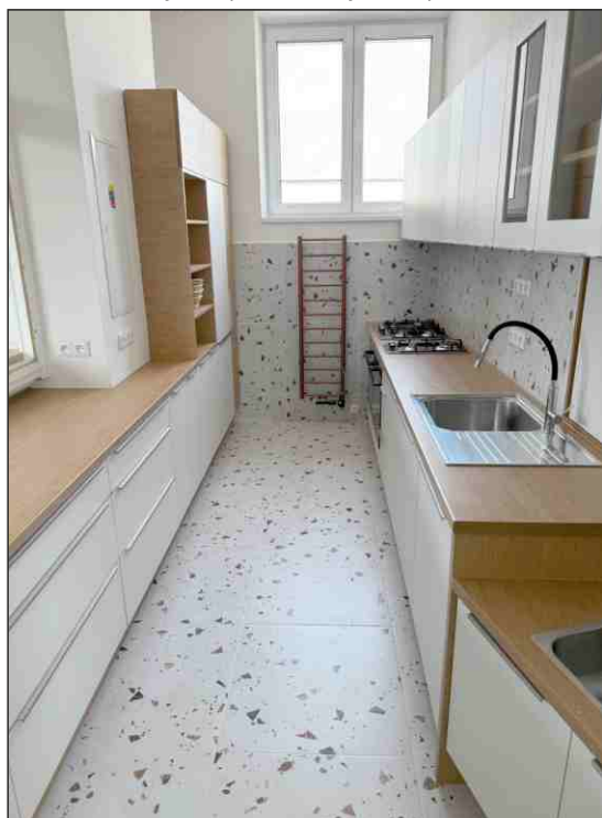
Rekonstrukce interiérů v hasičské zbrojnici
