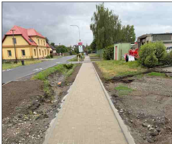
Chodník v ulici Bystřická
