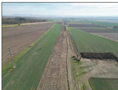
Pohled z dronu na trasu dálnice během skrývky ornice pohled z polní cesty spojující Kokory a Lukovou, směrem na jih k Rokytnici a Přerovu
