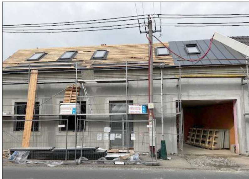
Budova Komunitního centra Velký Týnec dostává střešní krytinu. Stavba pokračuje podle plánu...
