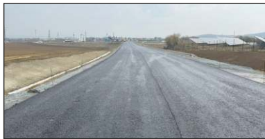
Křižovatka budoucí dálnice a spojnice Velkého Týnce s Grygovem už dostala první vrstvy asfaltu
