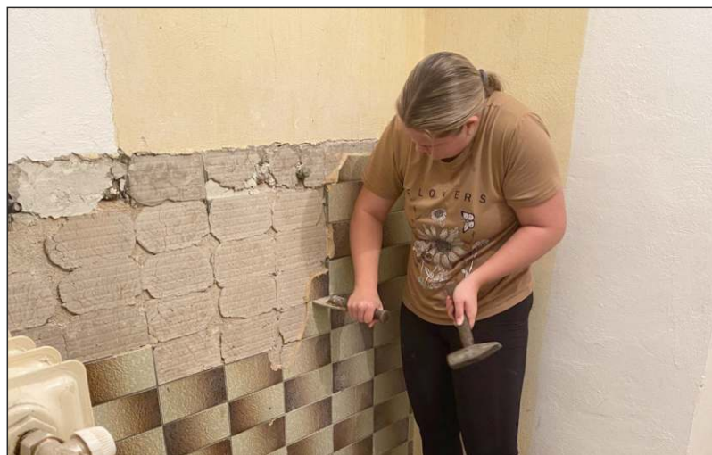
Do renovace interiérů hasičské zbrojnice se zapojily i hasičky
