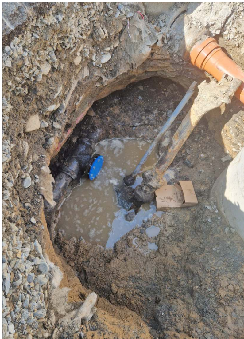
Oprava havárie na vodovodním řadu v ulici U Nové školy
