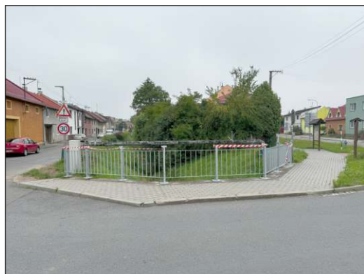
Nové zábradlí na Komárovském mostě...
