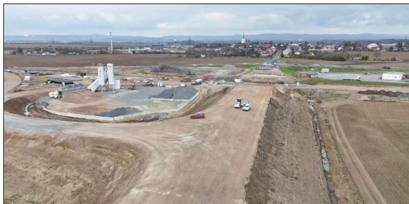
Pohled přes „nový most“ od Grygova na Velký Týnec
