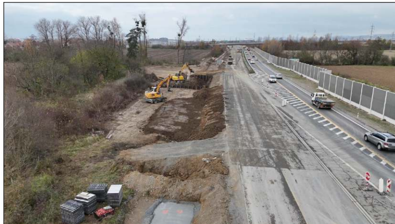
Úprava mostu přes Týnečku a stavba protihlukové stěny u Vsiska
