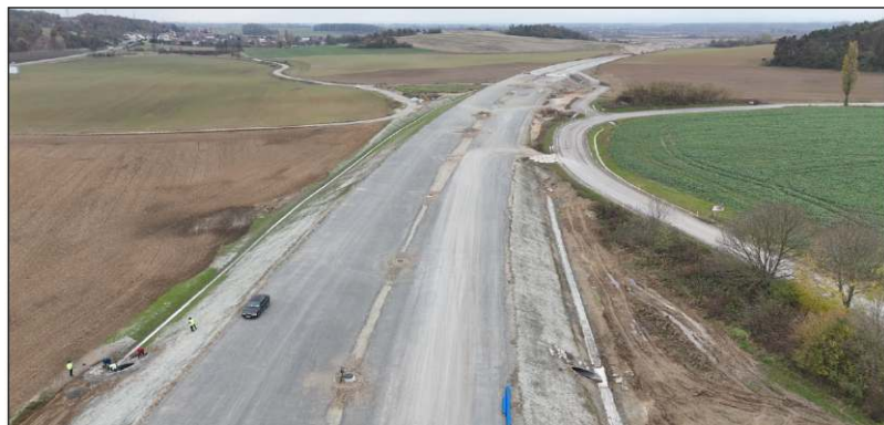
Před Krčmaní už stavba začíná připomínat autostrádu
